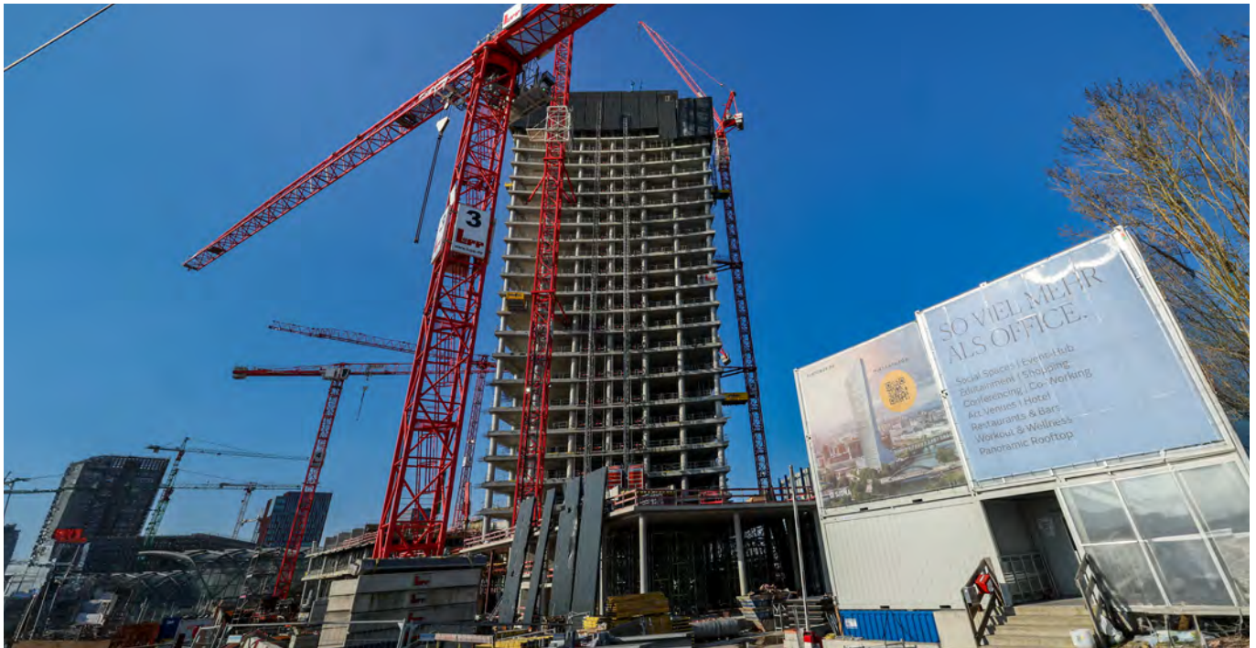
Hamburger Wolkenkratzer Elbtower: Das Objekt gehört zur Firmengruppe Signa des österreichischen Milliardärs Benko, die Baustelle ist seit Monaten verwaist.
